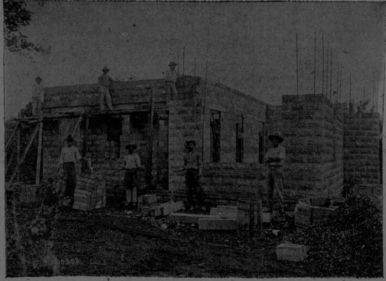
Modelo del sistema en construcción. Elegante chalet construido en cinco semanas con solo seis operarios
